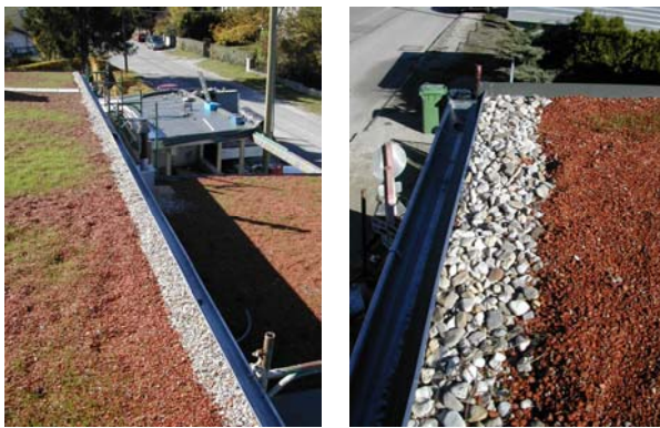
Abb. 173 Beispiele für Randdetails auf einem Extensivdach
