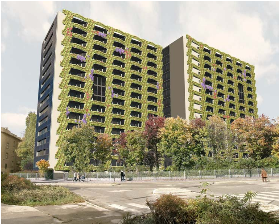
Abb. 248 Fassade mit Pflanzenschicht
