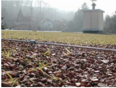
Abb. 172 Mineralisches Substrat einer Leichtbegrünung
