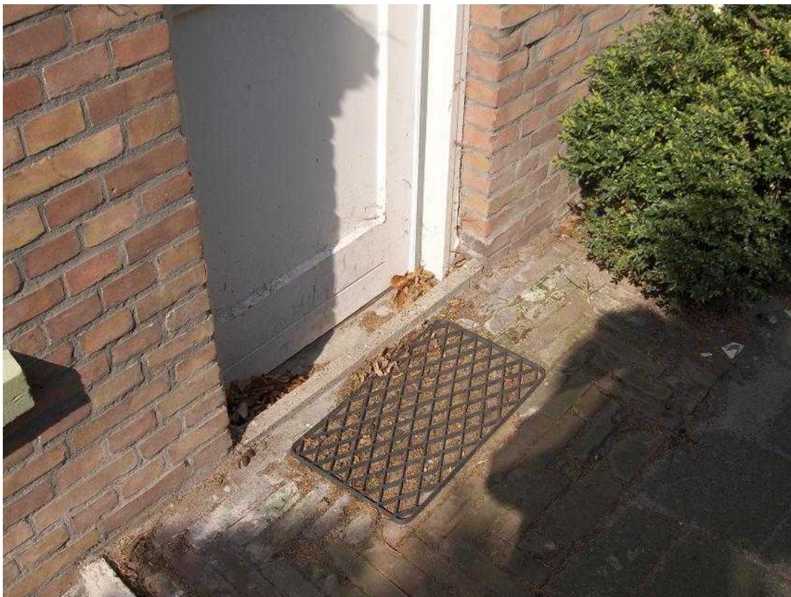
De begane grondvloer ligt lager dan het verlagde gedeelte in de straat.
